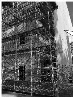
仮設足場の設置
