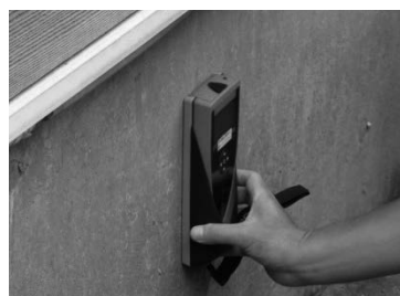
基礎配筋の調査
